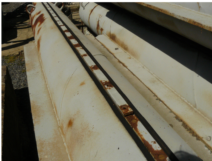
Foto č.2 – těsnící profil a přítlačná lišta
